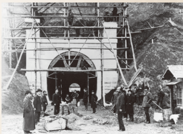
第1疏水第2トンネル東口で洞門工事（明治21年）
